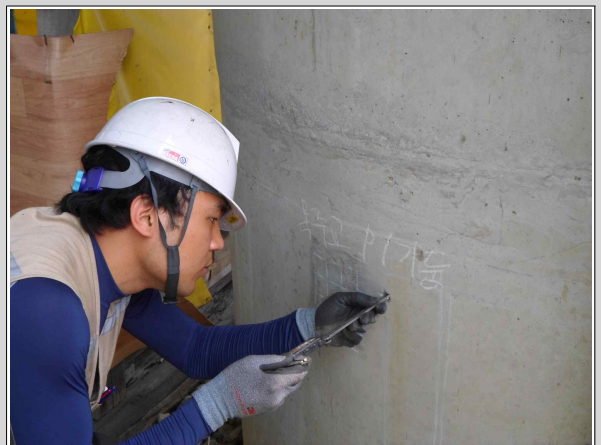
탄산화 깊이 측정
