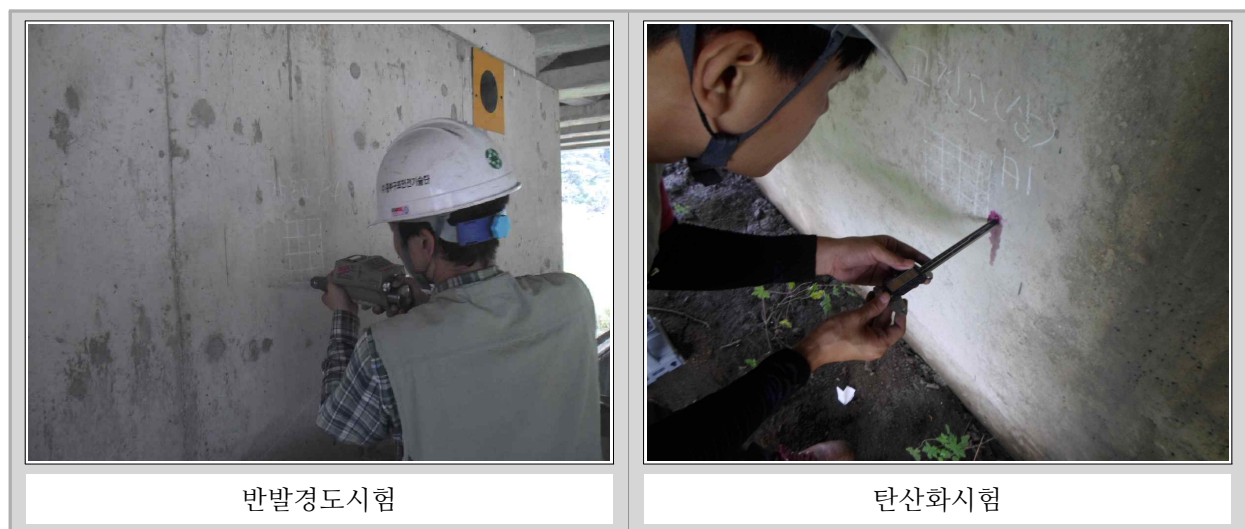
〈그림 3.1.1〉 콘크리트 압축강도시험 및 탄산화시험
