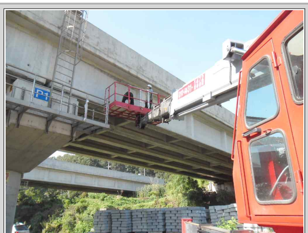
고소작업차를 이용한 외관조사 전경
