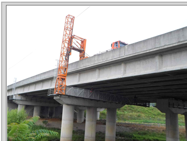
교량 점검차를 이용한 외관조사 전경
